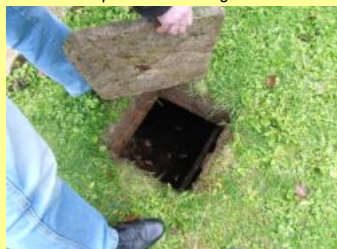
Tampons de puits – puisards
